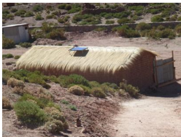
6. Solaranlagen auf einem Dach eines Hauses in einem Dorf in der Atacama Wüste
