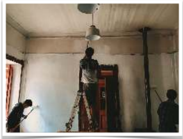
Voller Einsatz: Renovierungsarbeiten in der Casa
